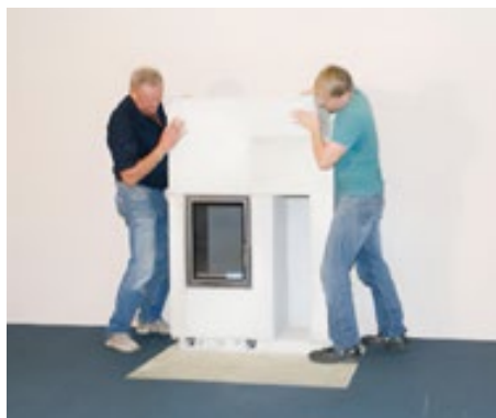
Verkleidungselemente Stück für Stück zusammensetzen und verkleben
