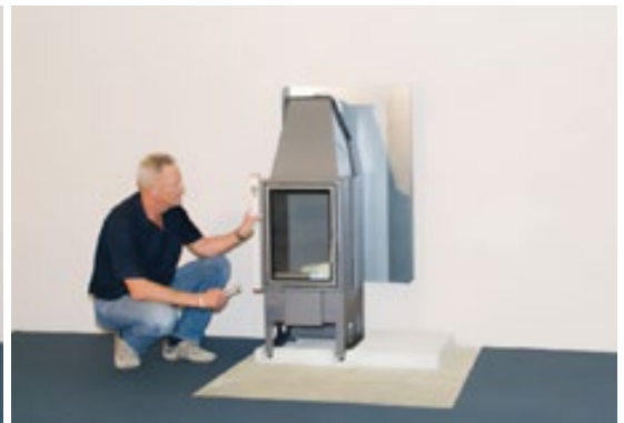
Kamineinsatz mit Wasserwaage einrichten
